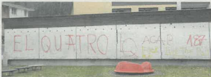
Beschmierte Wand in Schüttdorf.
